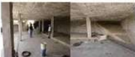
Figura 7 Estructuras en construcción ATACABA (Fotografía propia)
