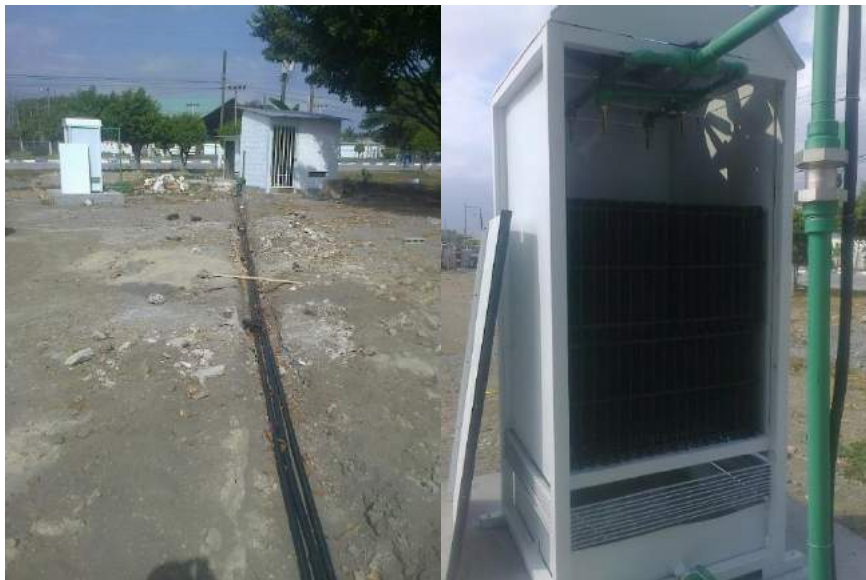
Figura 1: Detalle del sumidero y la torre de enfriamiento en la Base Naval Sur.
